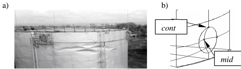
1 pav. Įduba viršutinėje sienutės juostoje (a) ir nagrinėjamieji įdubos modelio taškai (b): defekto centre (žymė mid ); kontūro linijos viršuje (žymė cnt )
